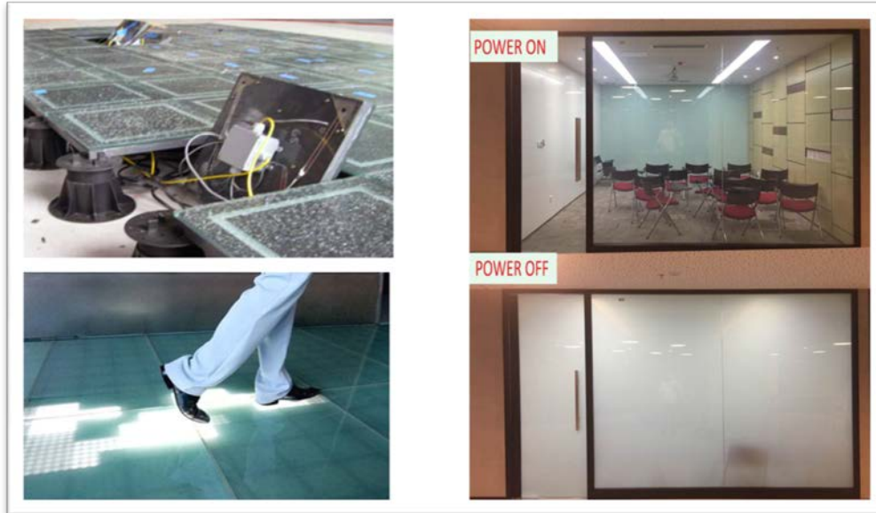
شكل ( 7 ) : بلاطات الأرضية التفاعلية ، والزجاج المدعم برفائق للتحكم في درجة شفافيته
