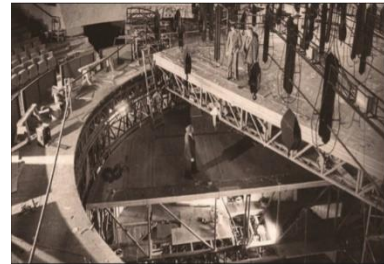
شكل رقم 6 Drum of steel: تدور الأسطوانة في موقف سيارات لشركة المصنعة Mole Richardson ثم تم تثبيتها في مسرح الأوليفيه Olivier
