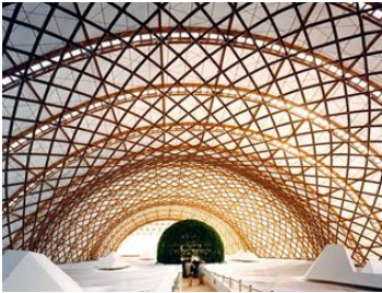
شكل (16 ب) يوضح جناح اليابان بمعرض هانوفر بألمانيا من تصميم شيجيروبان وتنفيذ المبنى بالورق المقوى ، 2000 7
