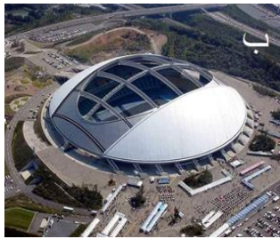
( ب ) توضح لقطة خارجية للمبنى أثناء فتح السقف ويحدث هذا عندما يكون الجو معتدل ،
