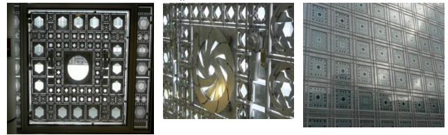
شكل (19 أ، ب، ج) يوضح تصميم الواجهات الذكية في مبنى معهد العالم العربي بباريس، حيث قدرتها على التحكم في كمية الإضاءة النافذة الى الحيز الداخلي 15
