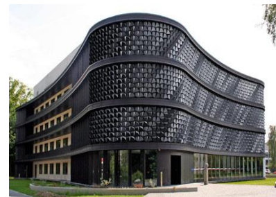
شكل (20) توضح التصميم الخارجي لواجهه مبني the FLARE16
