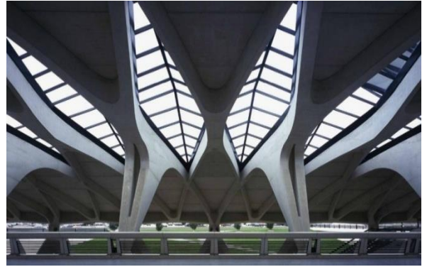
شكل (14) يوضح الفراغ التشكيلي الإنشائي الداخلي للصالة من الخرسانة المسلحة6
