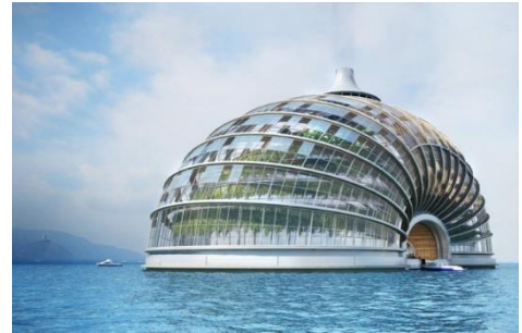
شكل (15) لمبنى the ark يوضح الهيكل الخارجي المكون من الزجاج ذاتي التنظيف
