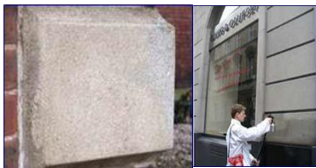
(شكل 34) يوضح دهان النانو على الحجر بواجهات المباني (في الصورة العلوية بدون معالجة والصورة من أسف الحجر المعالج)
